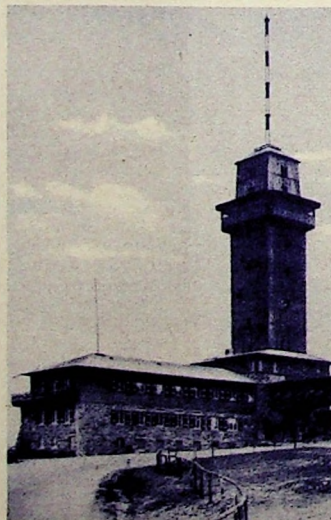
Bild 1. Der UKW-FM-Sender Feldberg arbeitet mit einer Pylon-Rundstrahl-Antenne
